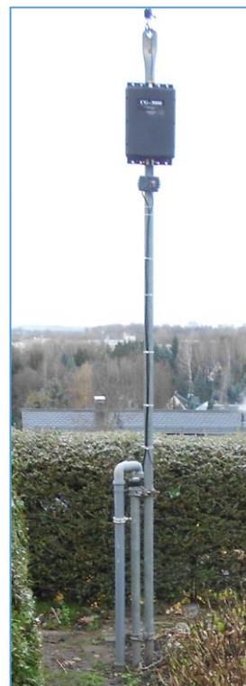
Hinweis: Der Tuner wurde mit der vorgesehenen Anschlussmöglichkeit nicht mit GND verbunden. Hintergrund: Die Zuleitung zum TRX erfolgt über das beschriebene unterirdisch verlegte Koaxialkabel. Dieses stellt das Gegengewicht dar.
